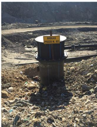
*Figura 14: Pozzo di captazione del biogas*
